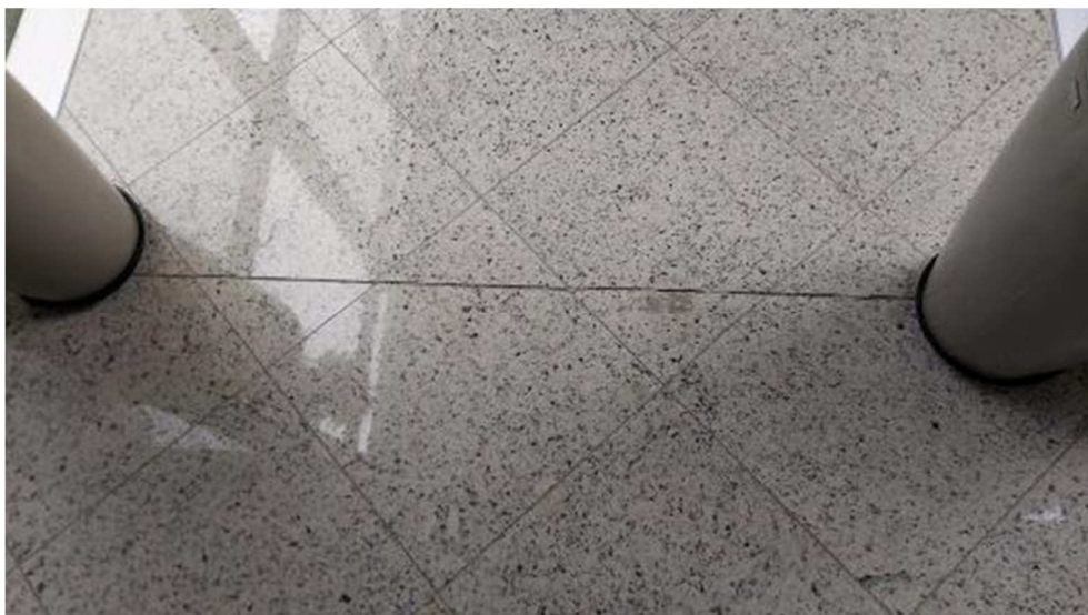
Detalhe da junta de movimentação sem tratamento (5º andar)
